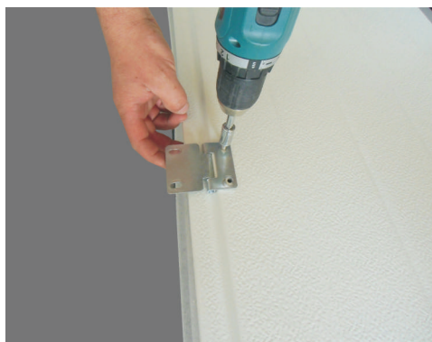
CZ Montáž středových pantů DE Montage von mittleren Scharnieren
